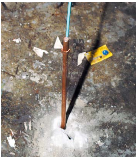
▲早期的電源接地是鑿孔埋入銅棒到潮溼的土裡，再連結16mm平方導體的接地電纜，以儘量降低接地阻抗。
