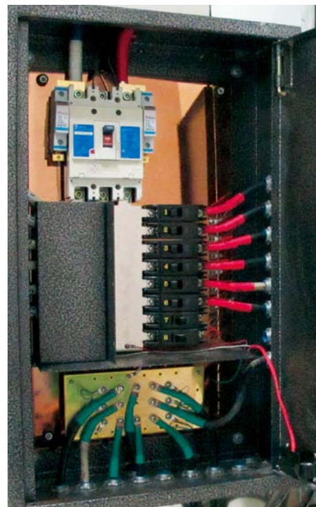
▲這是超大級的MA隔離電源箱，總共可輸出八回路，目前用家只用到六路而已。
